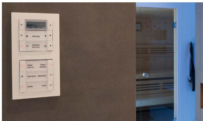
Auf Gira Tastsensoren im Schalterdesign »Gira E2« lassen sich Heizung und Jalousien bedienen, Lichtszenen sowie das Gira Unterputzradio aktivieren – alles über einen intelligenten Schalter, der bei Bedarf umprogrammiert werden kann.
